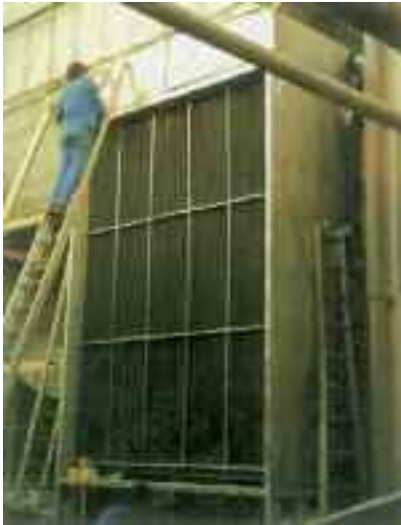
Duct heater 4000 kW for dehydraton in the agricultural industry Batterie chauffante 4000 kW pour déshydratation dans l'industrie agro-alimentaire.
